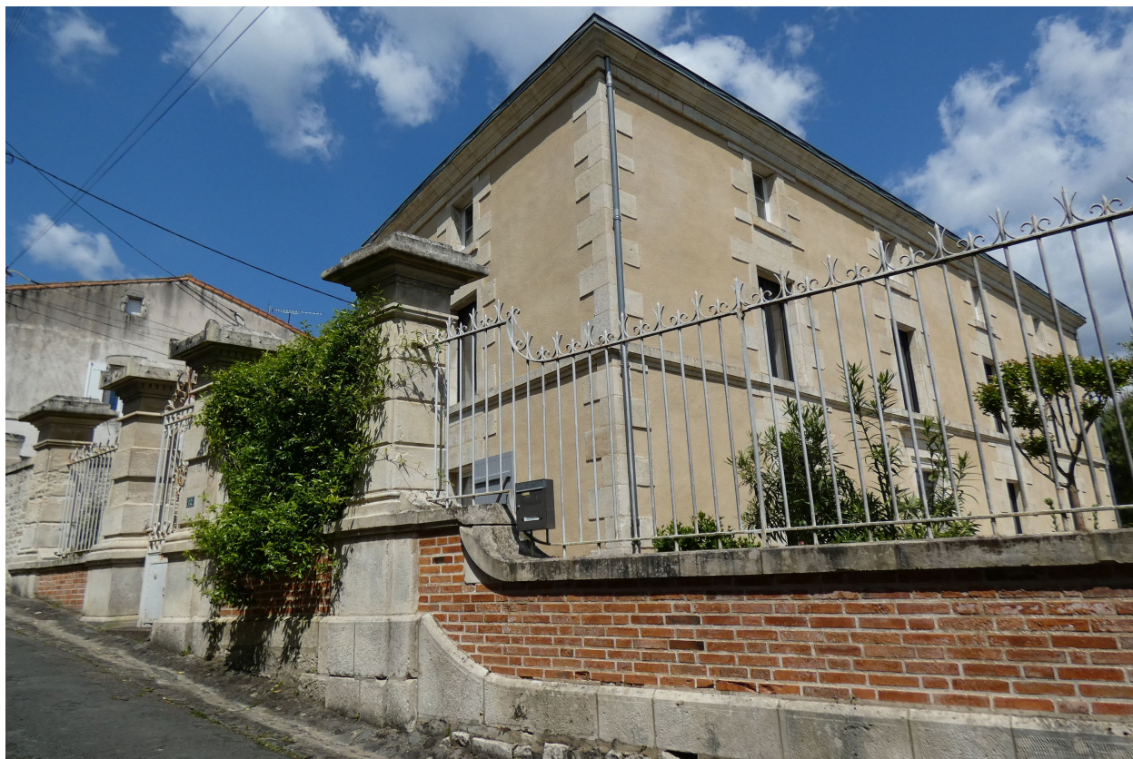
La maison et son muret de clôture vus depuis le sud.
