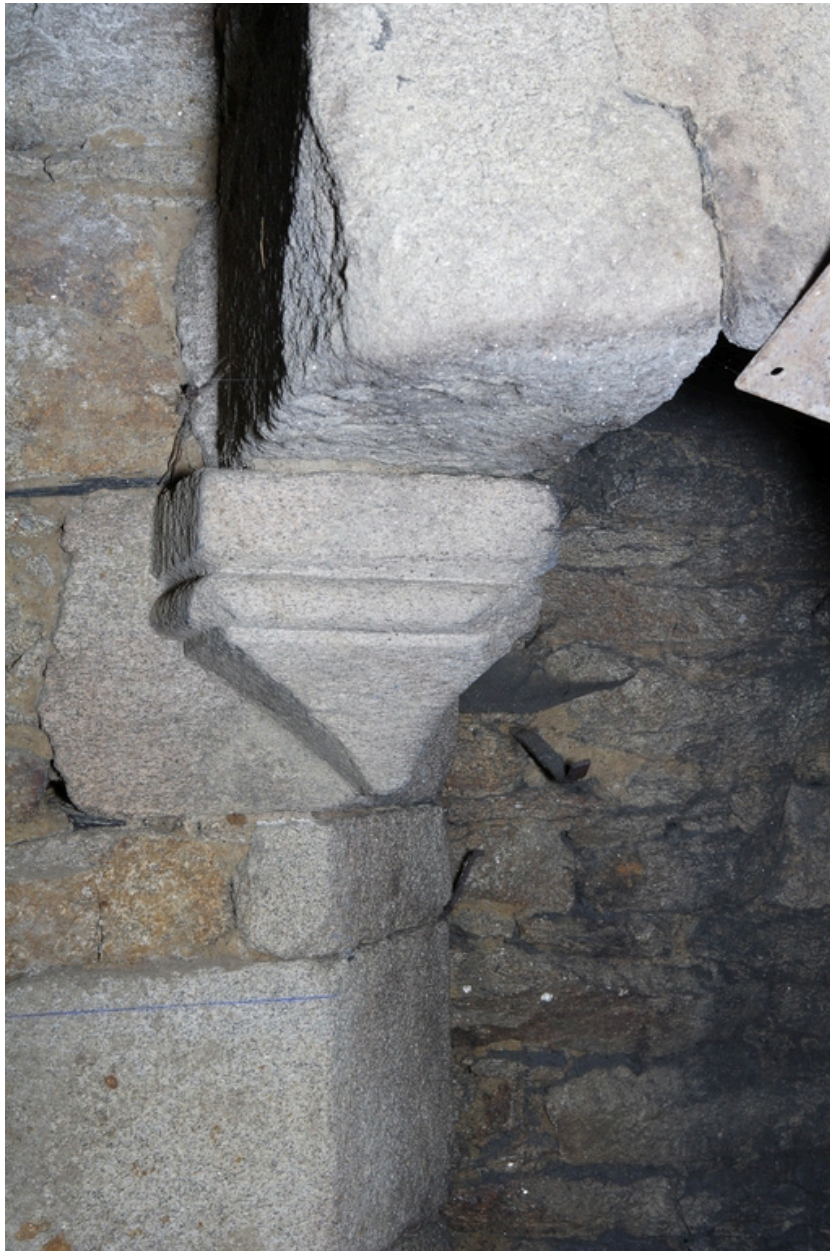
Bâtiment ouest. Détail du corbeau de gauche de la cheminée.
