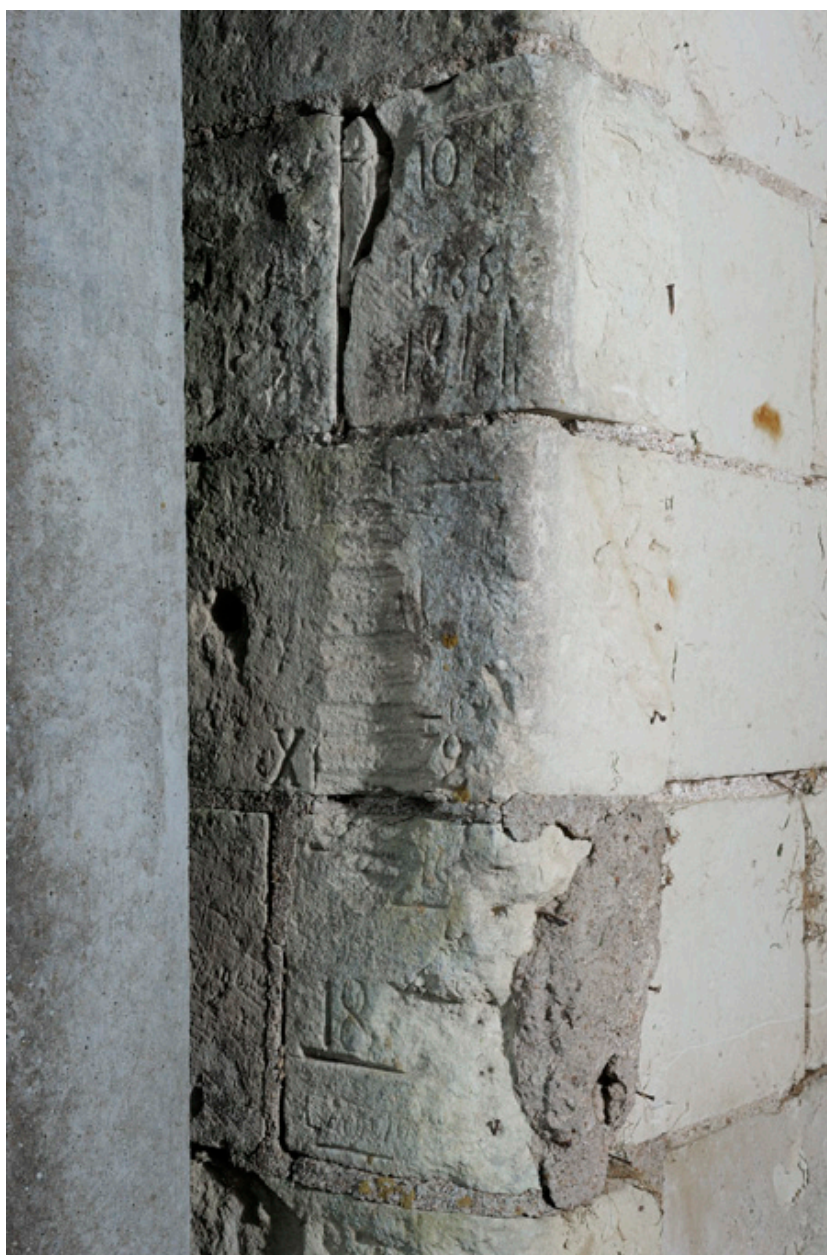
Portail du 5, rue du Port, avec repères de crues. Détail des assises basses (1836, 1844, etc.).
