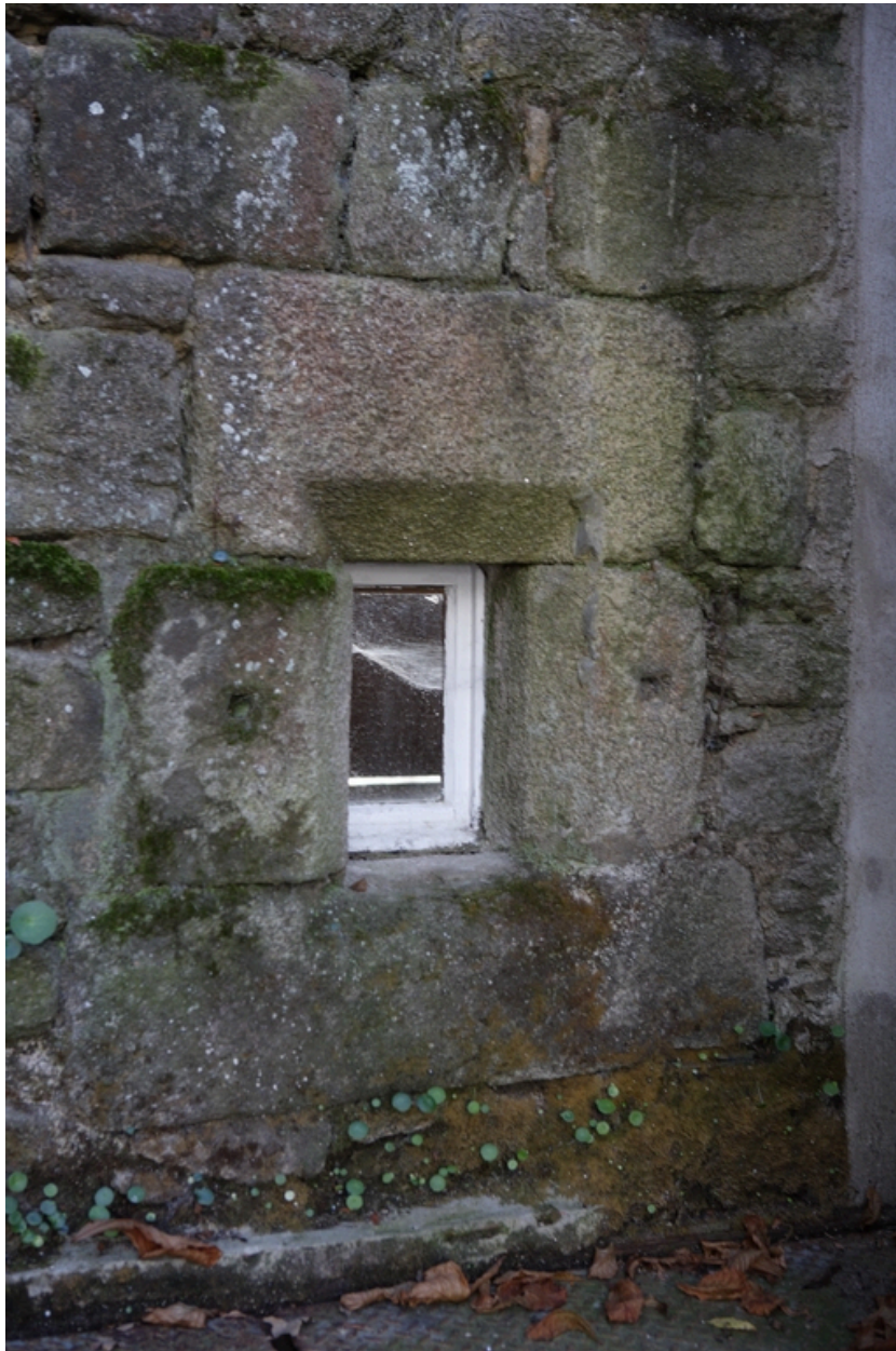
Logis. Cellier. Détail du soupirail.
