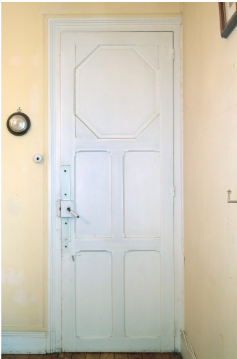
Porte de chambre au premier étage.
