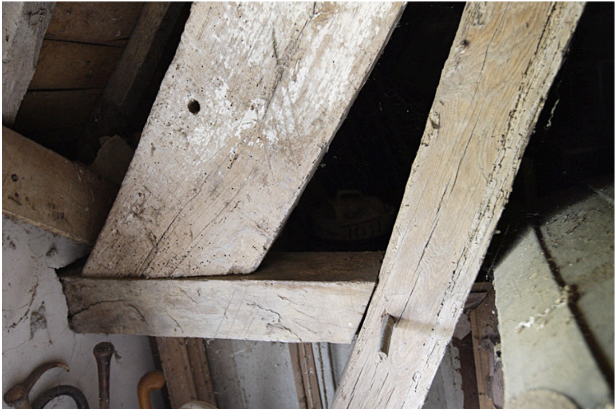
Logis. Charpente. Détail du blochet.
