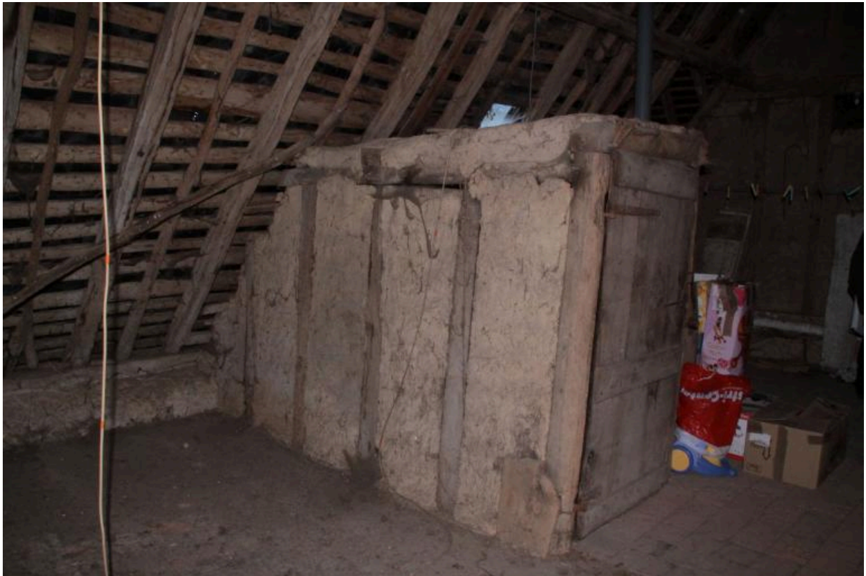
Faîtage de la cage d'escalier en pan de bois.
