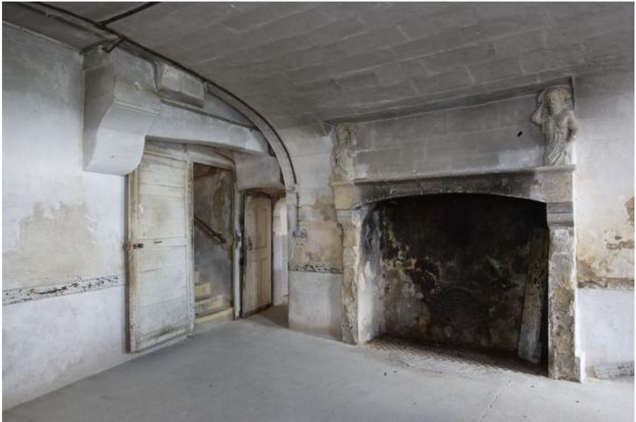
Le sous-sol du pavillon sud, cheminée.
