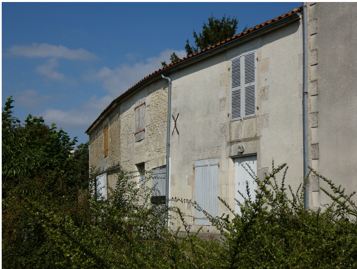
Les corps de bâtiments en arrière de la maison de gauche.
