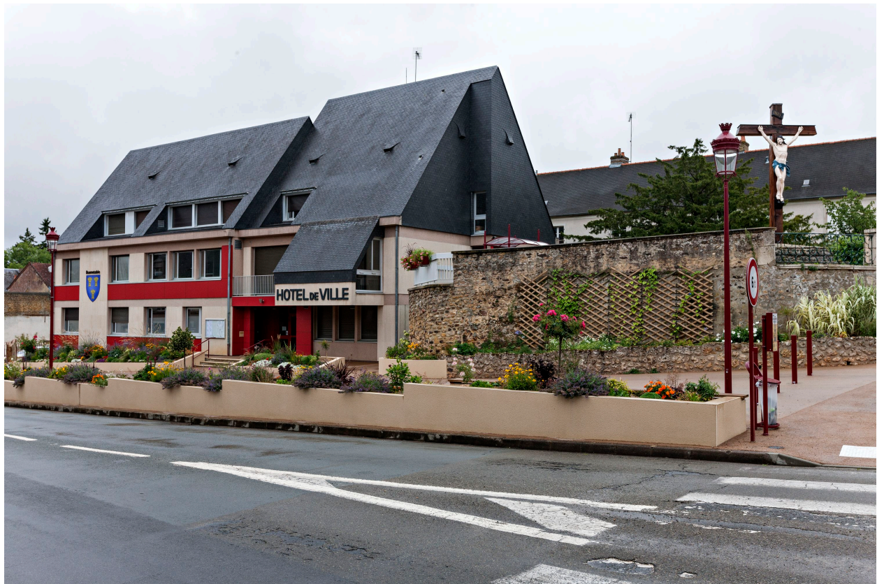
Vue de la mairie-centre de secours construite vers 1984 devant le presbytère.
