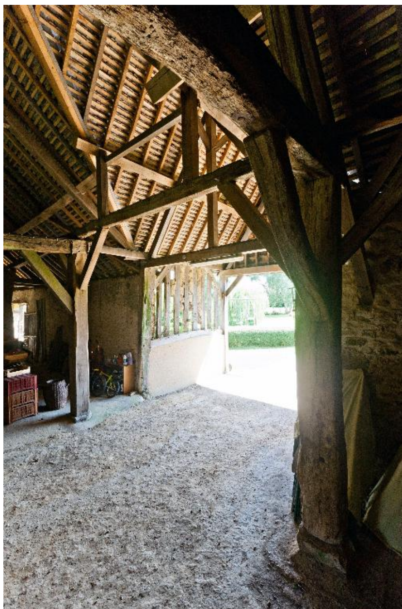
Vue intérieure du porche de la grange.
