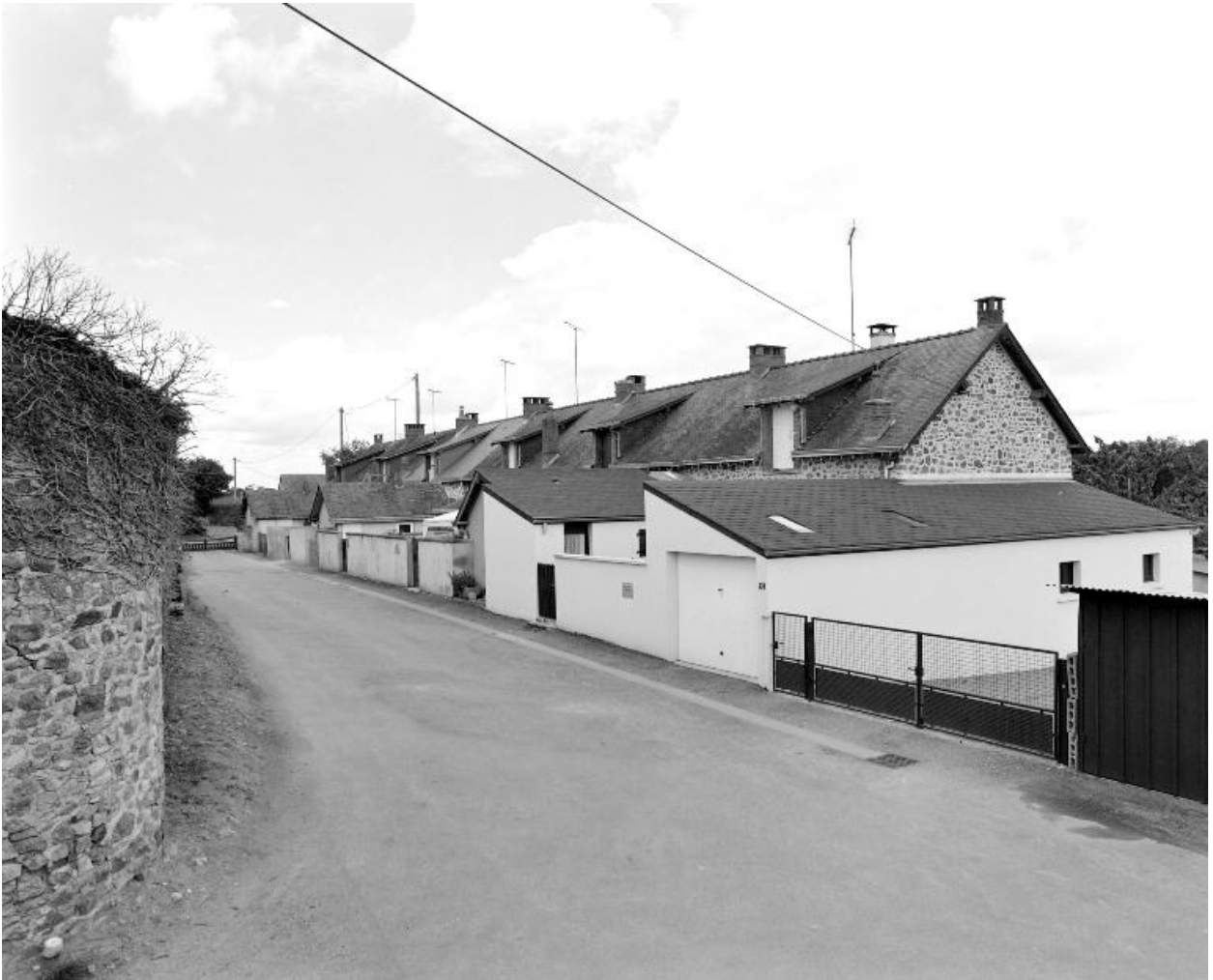
Façades postérieures, sur l'impasse, des maisons ouvrières en série situées rue du Buisson.
