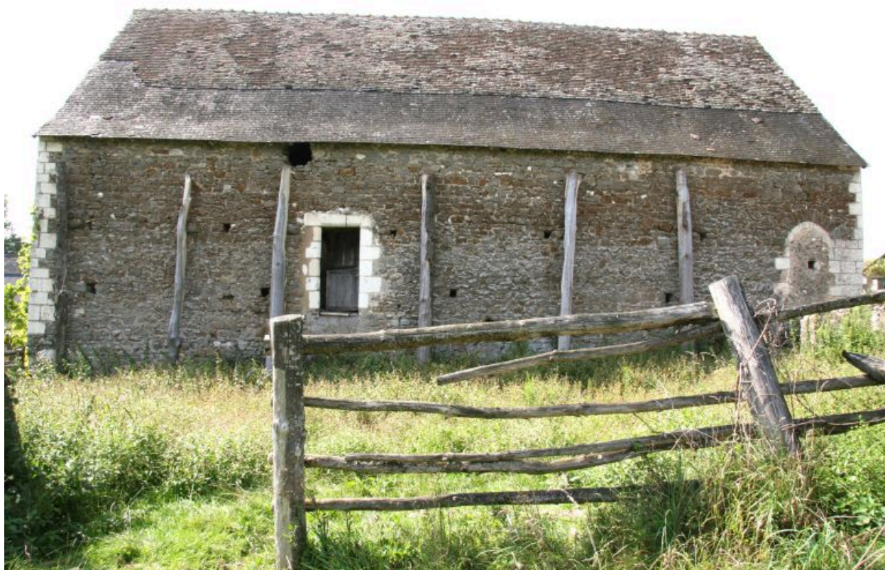
Le logis, façade orientale.
