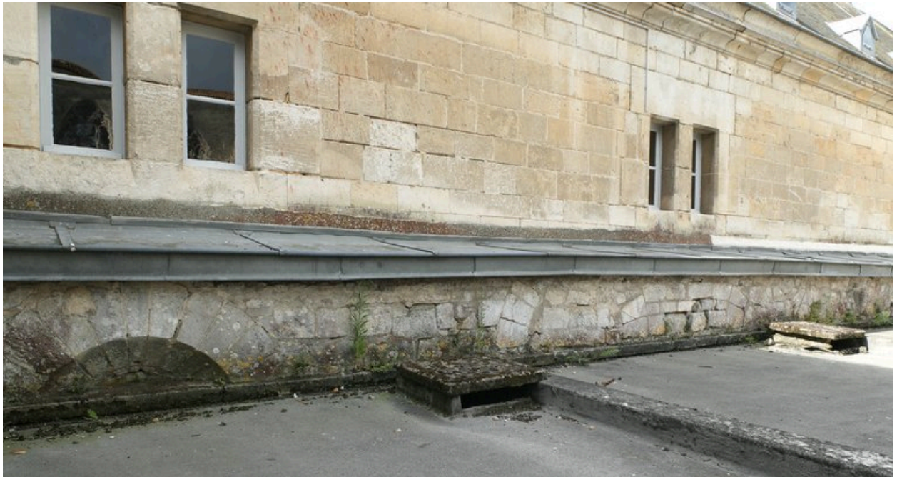
Aile sud du cloître : vue montrant la façade nord du bâtiment sud de l'évêché (vestiges du réfectoire médiéval).
