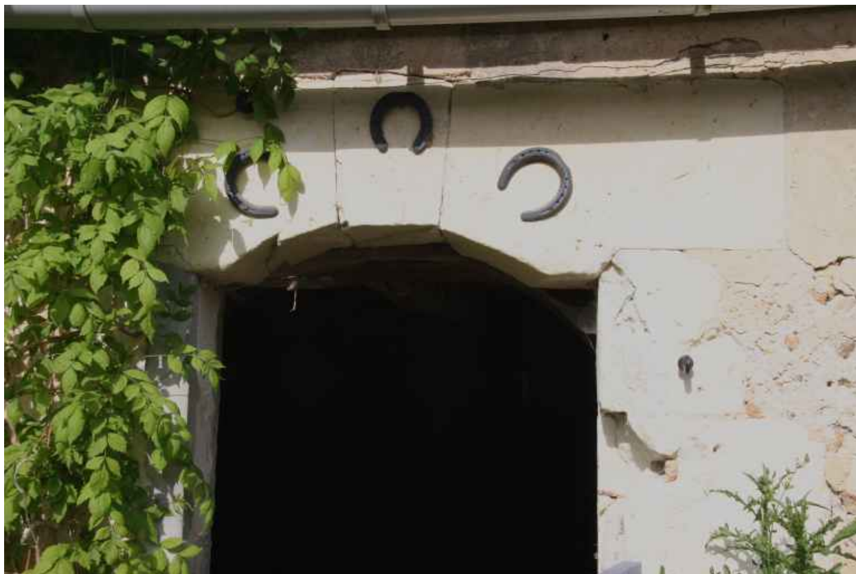
Porte de la chambre sans cheminée : linteau retailé.
