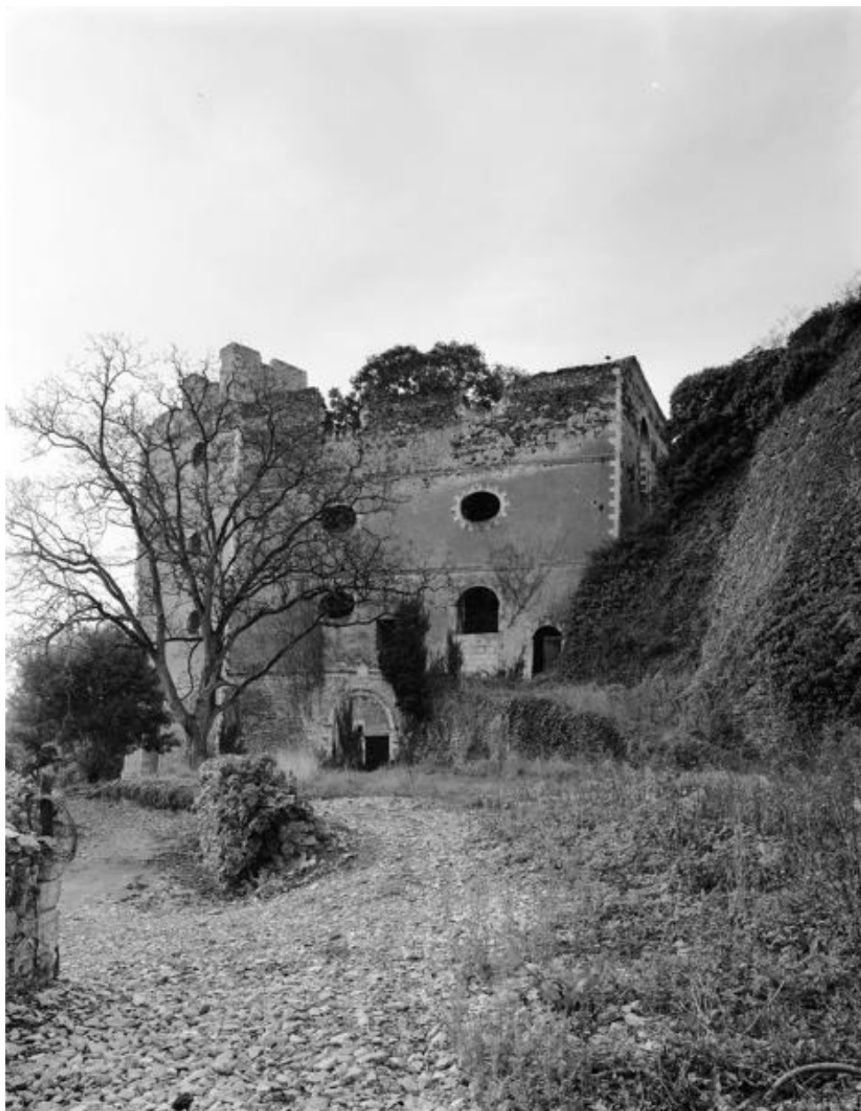
Bâtiment est, face nord-est, four à chaux de Sainte Barbe, Montjean-sur-Loire.
