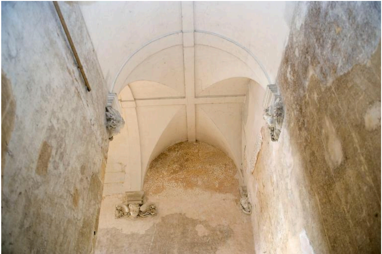
Le pavillon, voûte de l'escalier, 2007.
