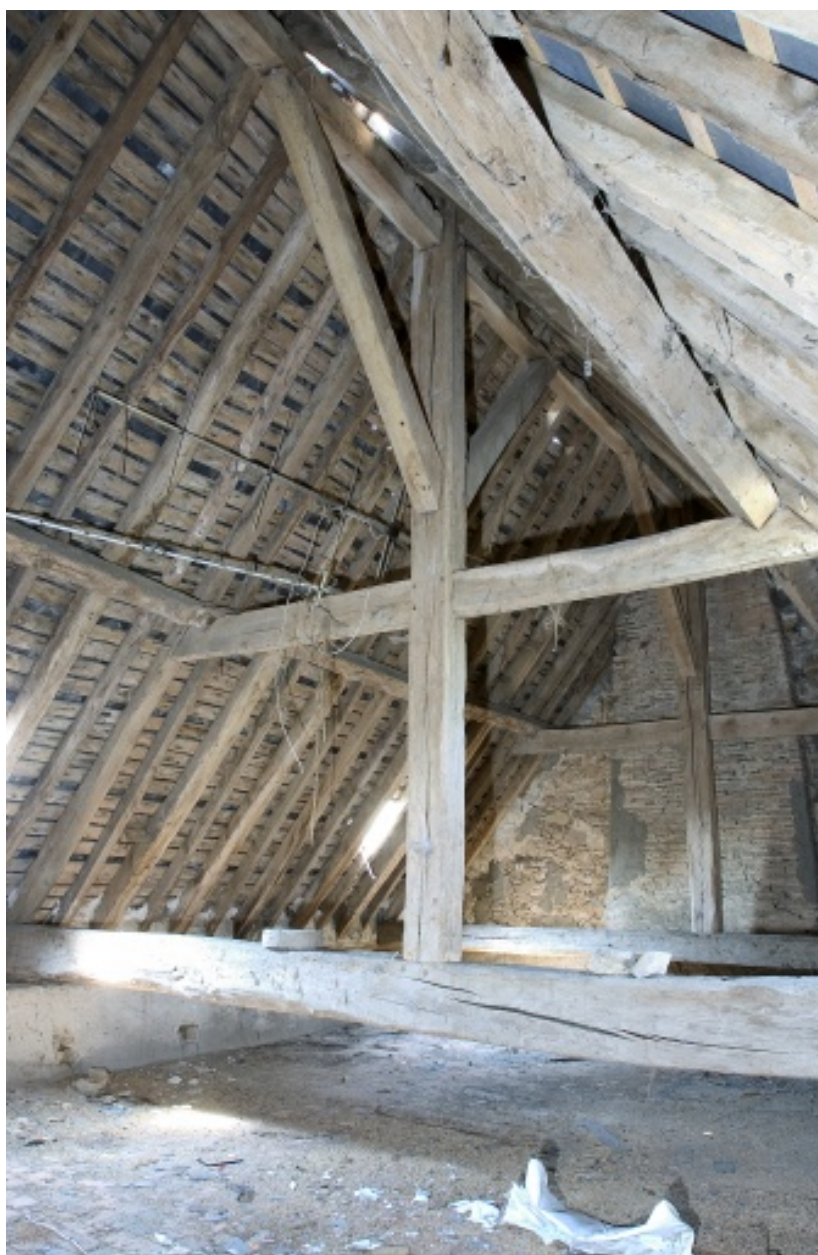
Intérieur du logis. La charpente vue depuis l'est.
