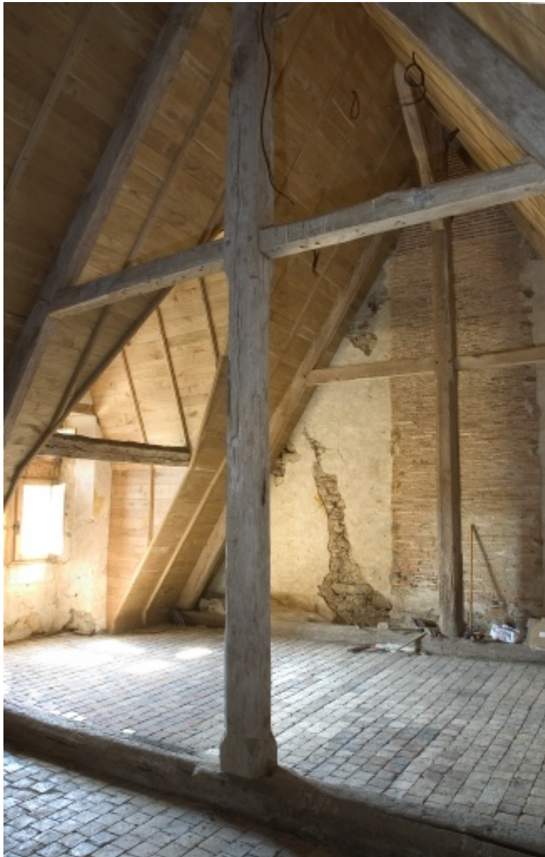
Intérieur du logis, comble : la charpente vue depuis le nord.
