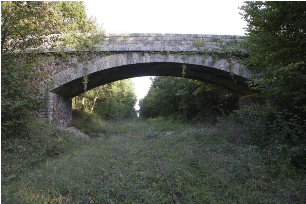
Pont-route maçonné
