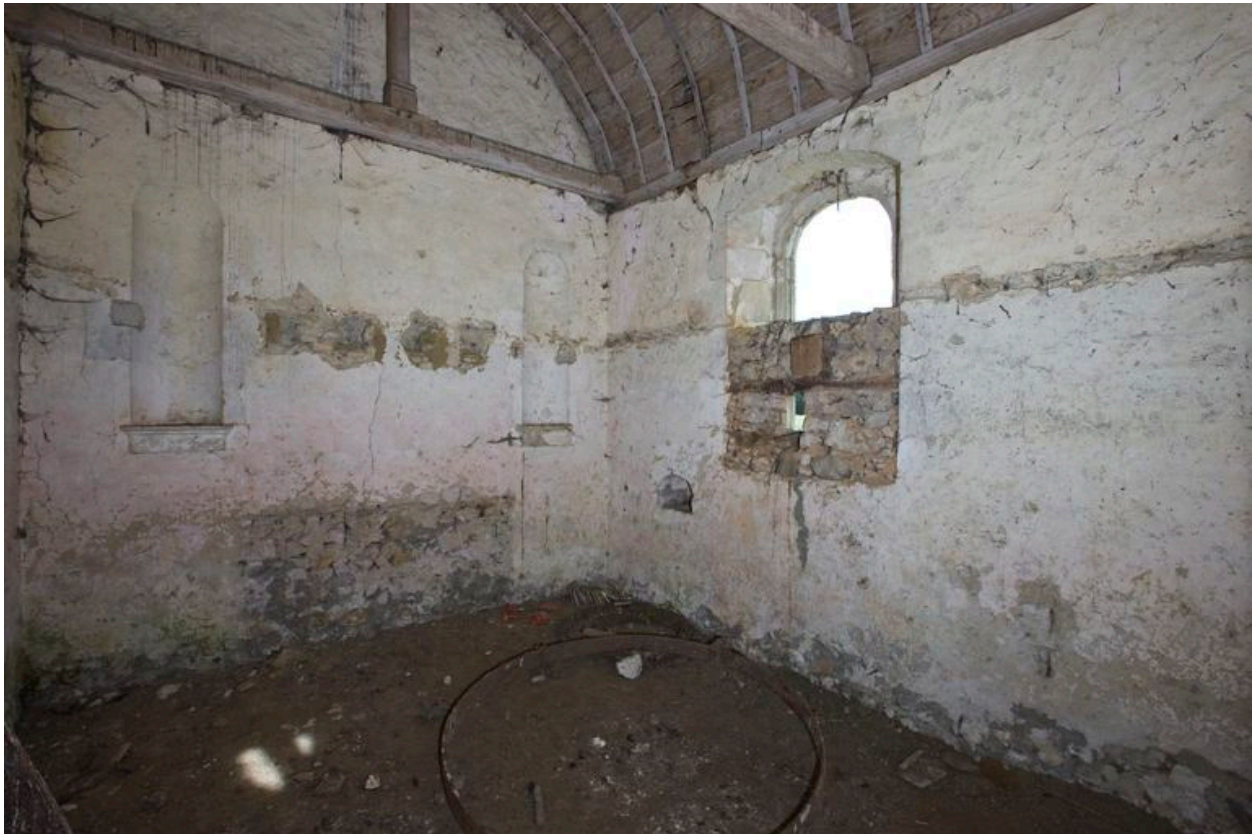
Vue intérieure depuis l'entrée
