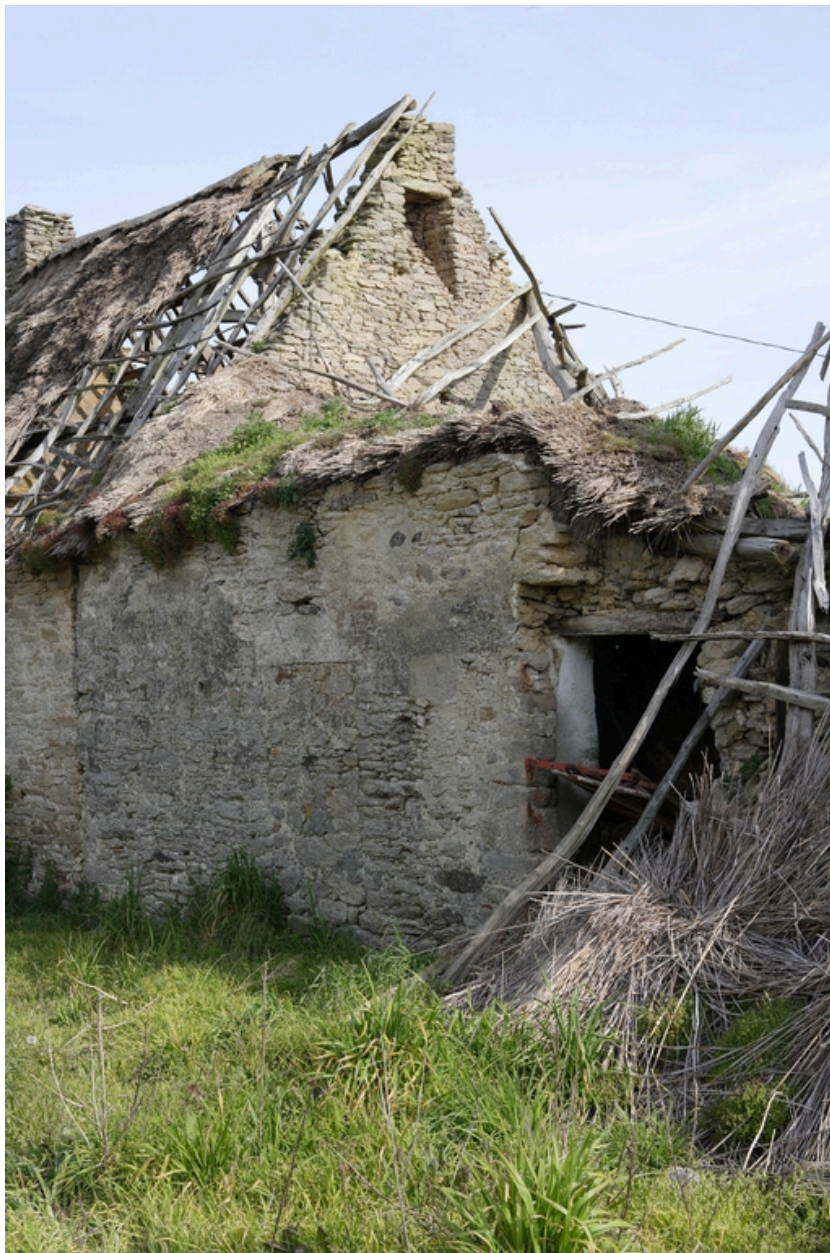
Détail du pignon ouest du logis est.
