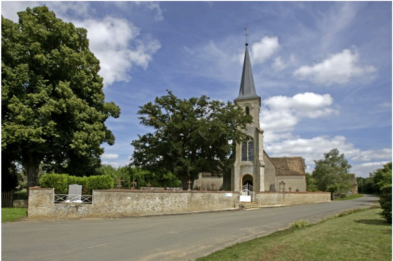
Vue de l'église et du cimetière depuis l'Ouest.
