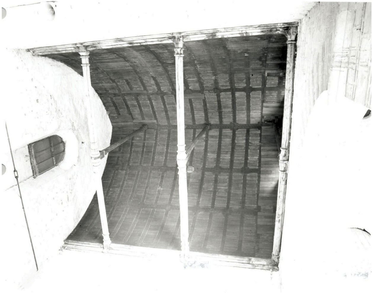
Collégiale Saint-Martin, croisillon nord du transept : charpente lambrissée en berceau brisé. A gauche, le pignon nord et à droite, l'arcade de la croisée.
