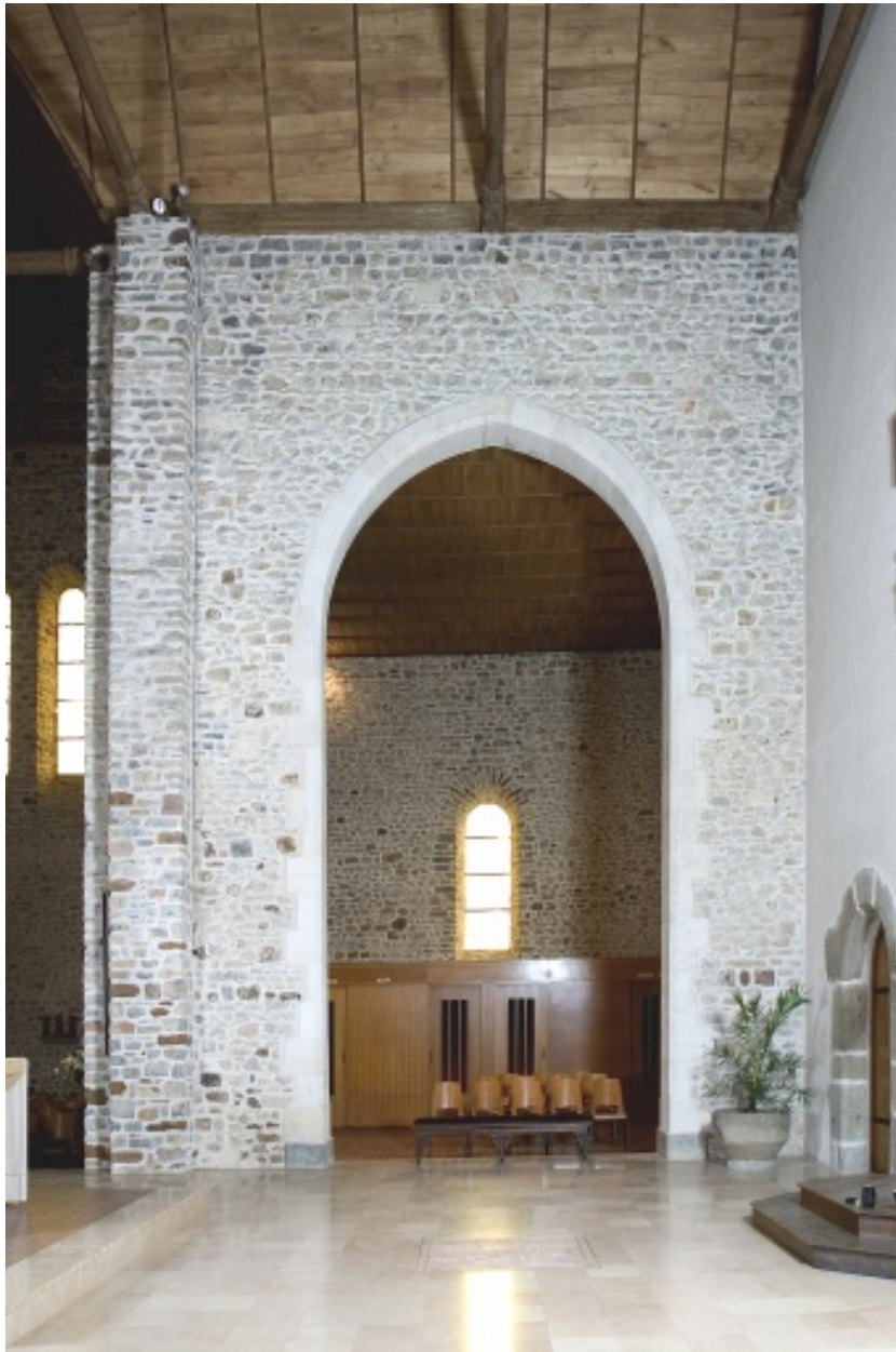
Vue intérieure : le mur nord du chœur et la chapelle nord.
