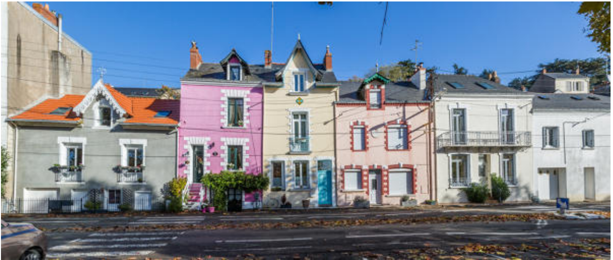
Alignement de maisons, quai Henri-Brunais.
