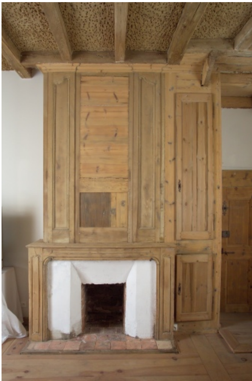
Cheminée du corps sud, premier étage.
