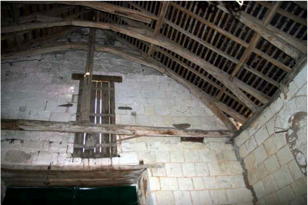
Charpente de la chapelle : ferme principale.
