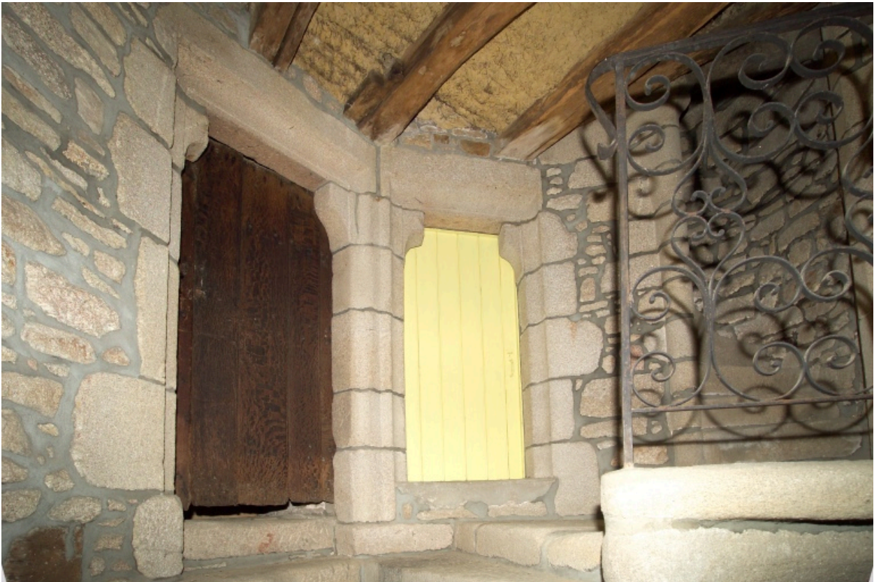
Cage d'escalier, palier du deuxième étage.
