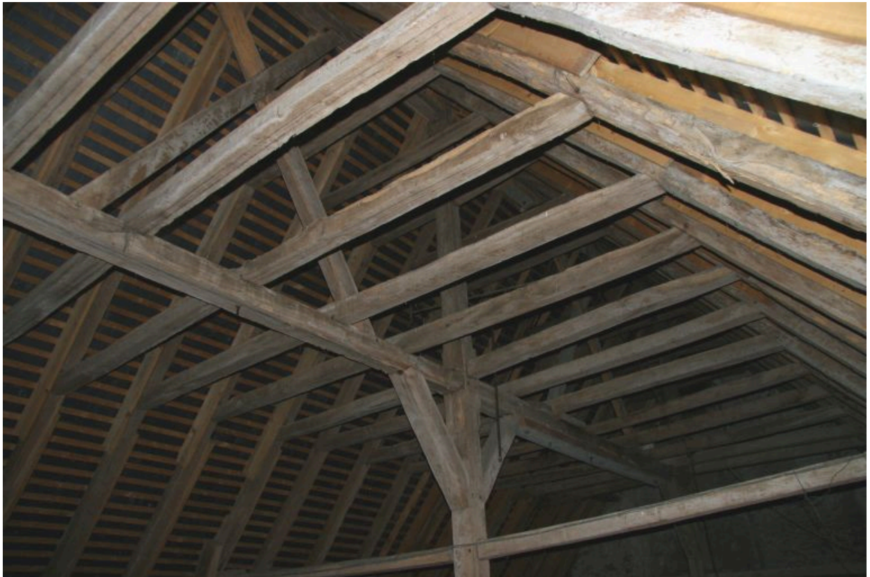
Le logis, aile fin du XVe siècle : charpente.
