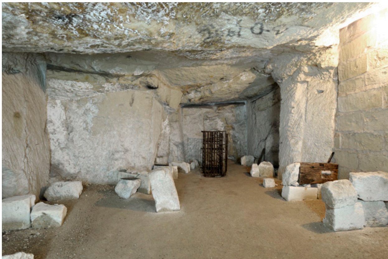
Cavité sud-est : cavités latérales de la galerie d'extraction du XIXe siècle (2).
