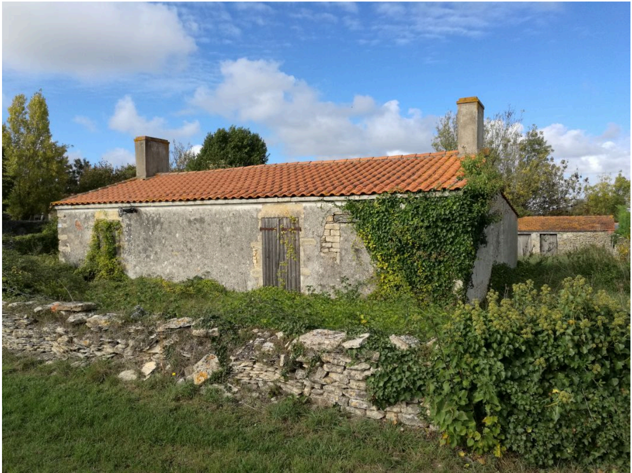
Maison en simple rez-de-chaussée, avec de petites dépendances, rue de la Voie.
