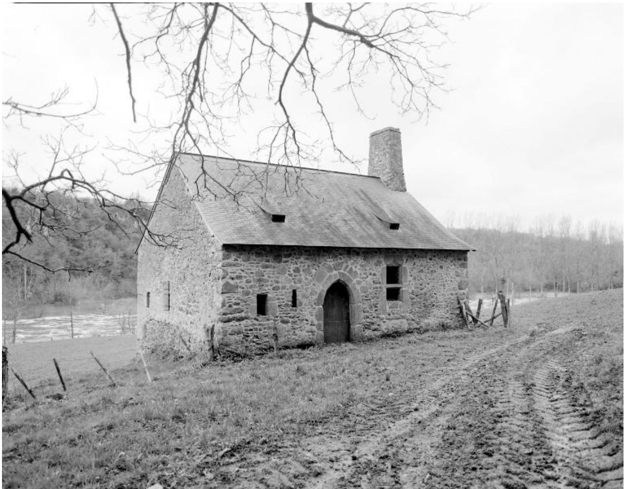
La façade principale (est) et le pignon sud.
