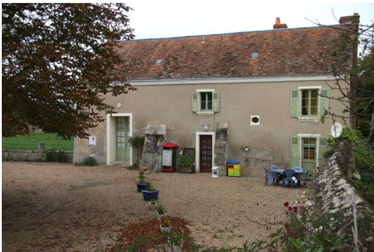
Façade antérieure sur cour.
