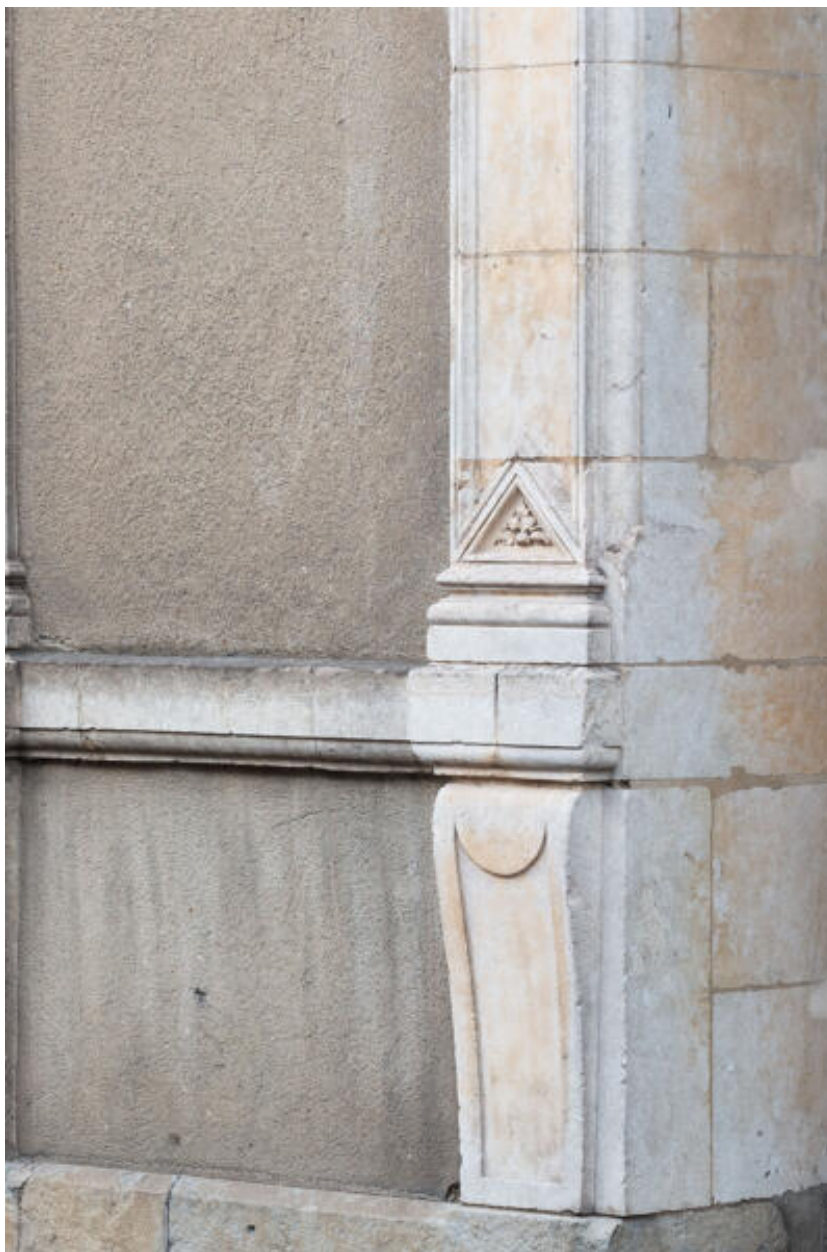
Vue de la partie inférieure du jambage de la porte d'entrée.
