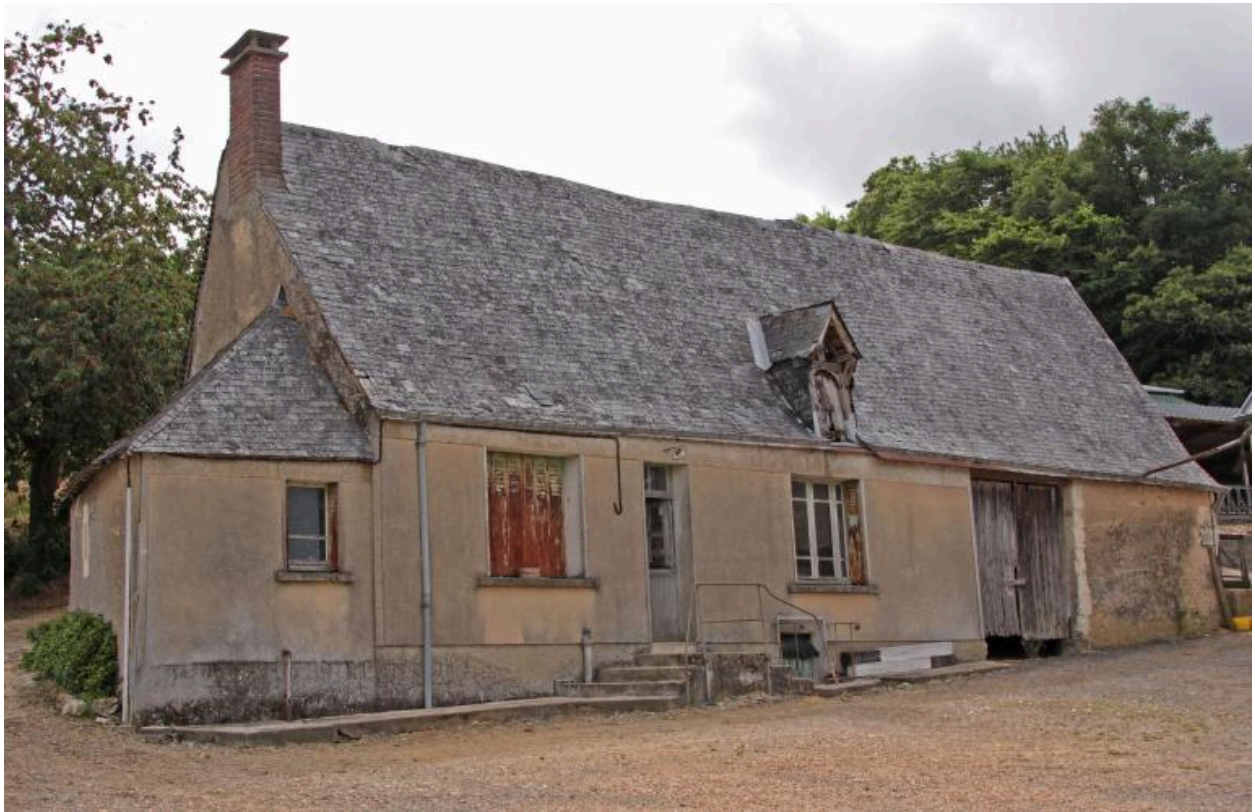
Maison : façade antérieure sur cour (ouest).
