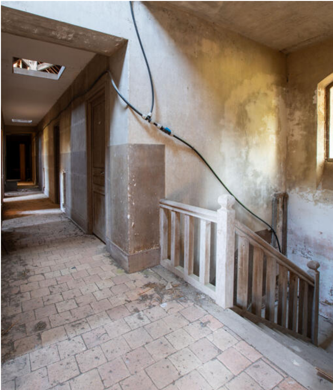
Le couloir et l'escalier des chambres des garçons d'écurie.
