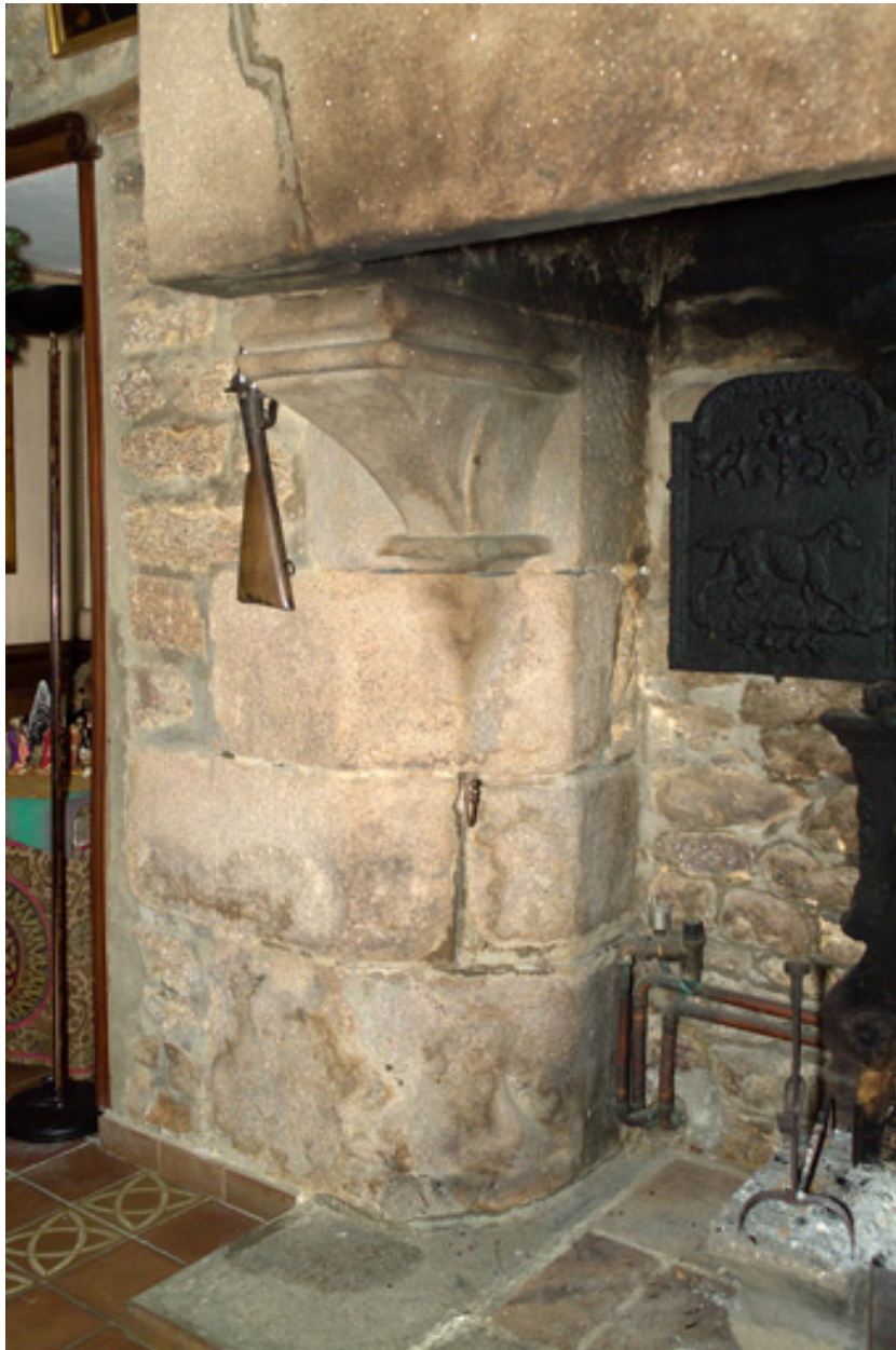
Rez-de-chaussée oriental, cheminée sur le pignon est, détail du montant gauche.
