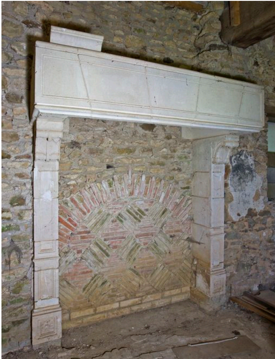
Logis, aile en retour : cheminée, 4e quart du XXe siècle.
