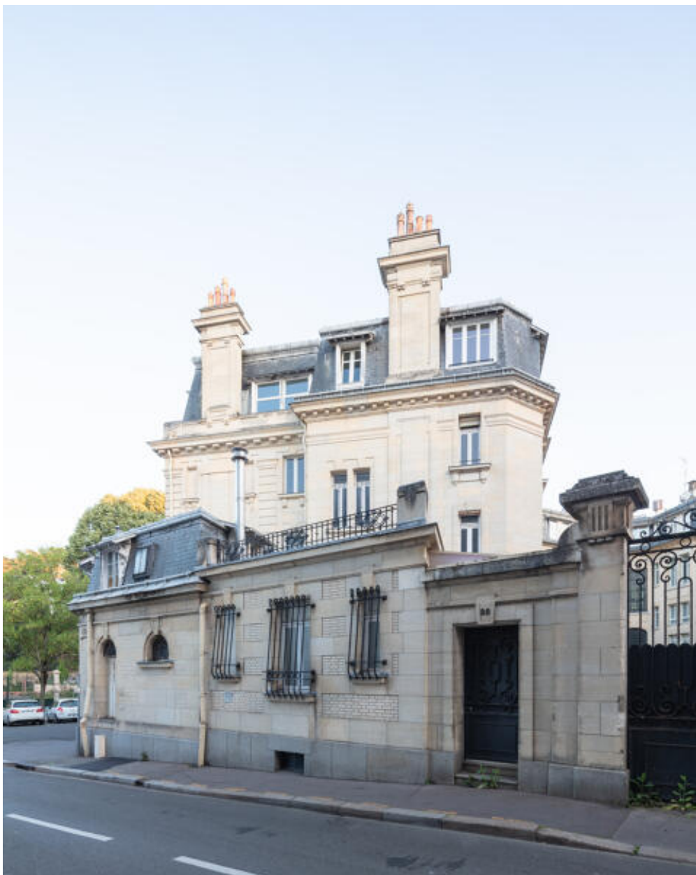
Vue de la façade latérale sud de la demeure du directeur des Mutuelles.
