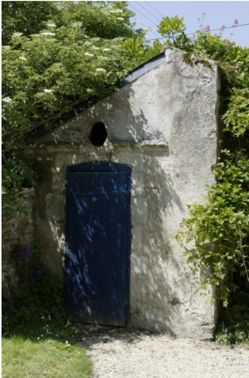
Anciennes toilettes de la cour d'honneur, contre le mur de clôture.
