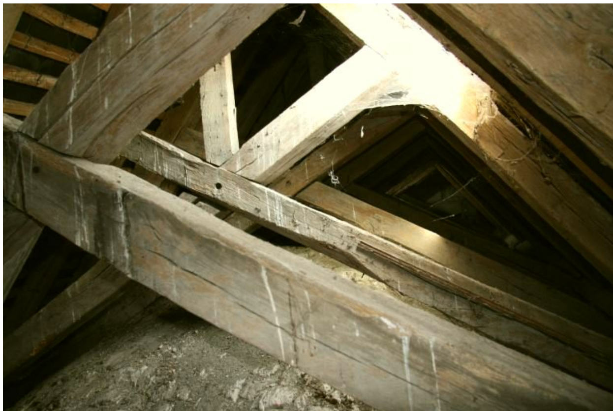
Charpente du chœur.
