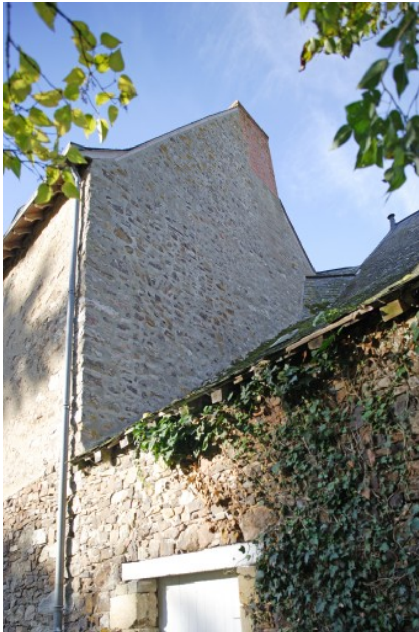
L'élévation latérale nord du corps principal.
