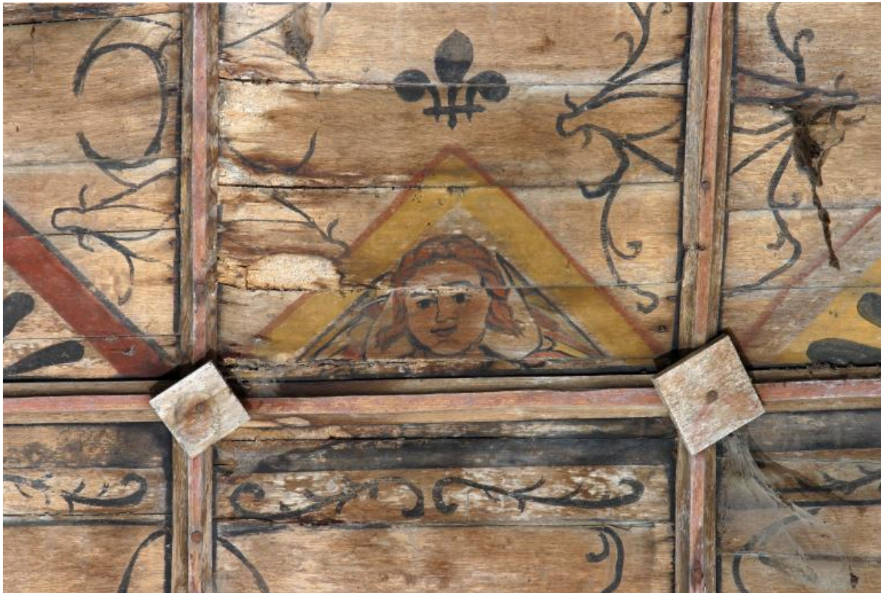
Nef, voûte, côté sud, première travée, registre de faîte : ange.
