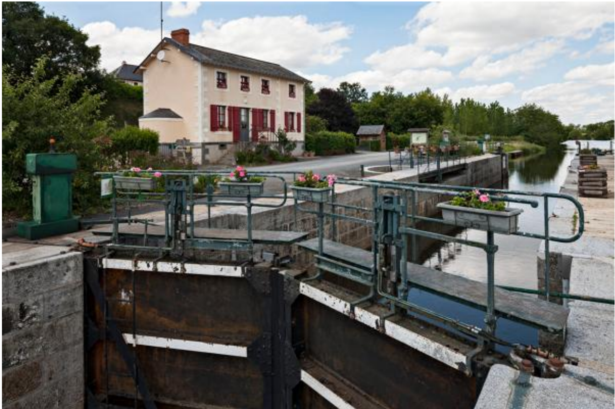
La maison éclusière et l'écluse vues depuis l'aval, au sud.
