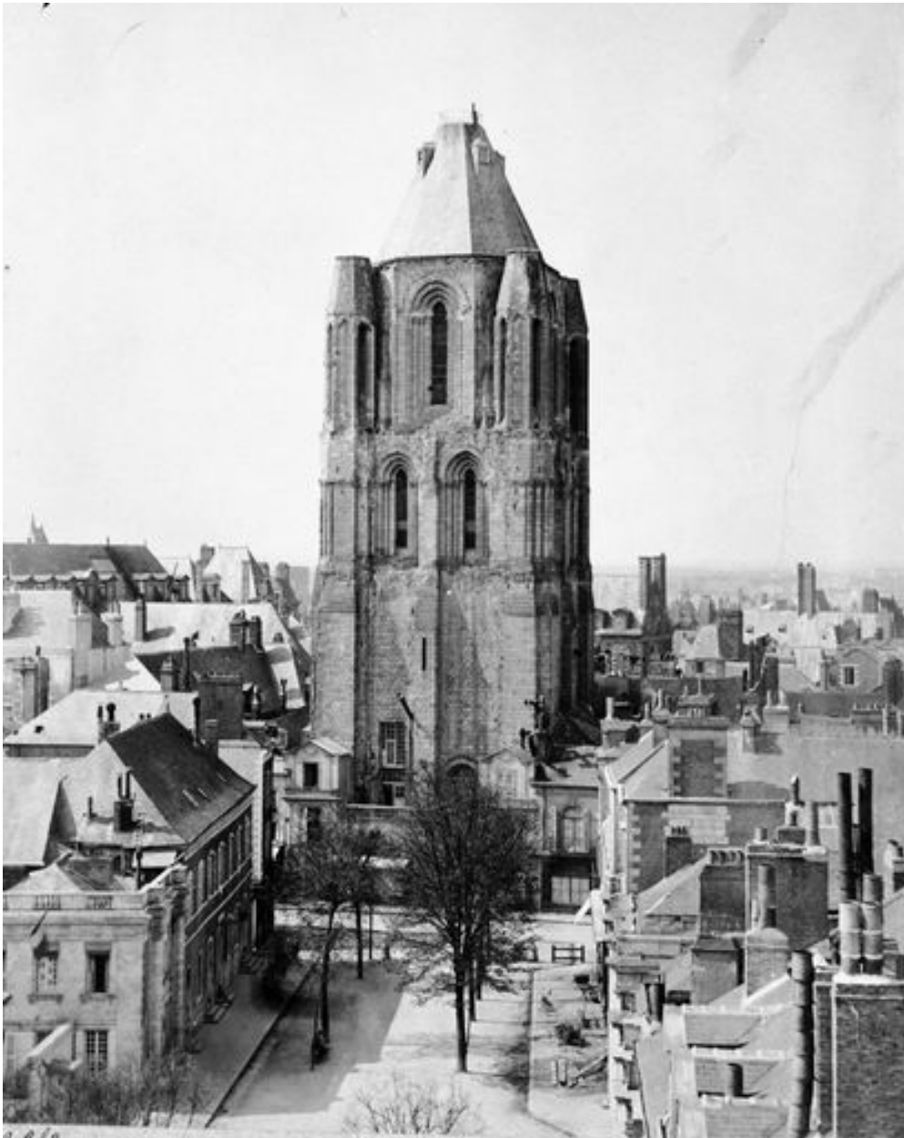
Vue générale à l'est de la tour Saint-Aubin, avant restauration, fotogr., fin 19e siècle. (Médiathèque de l'Architecture et du Patrimoine ; 2358).
