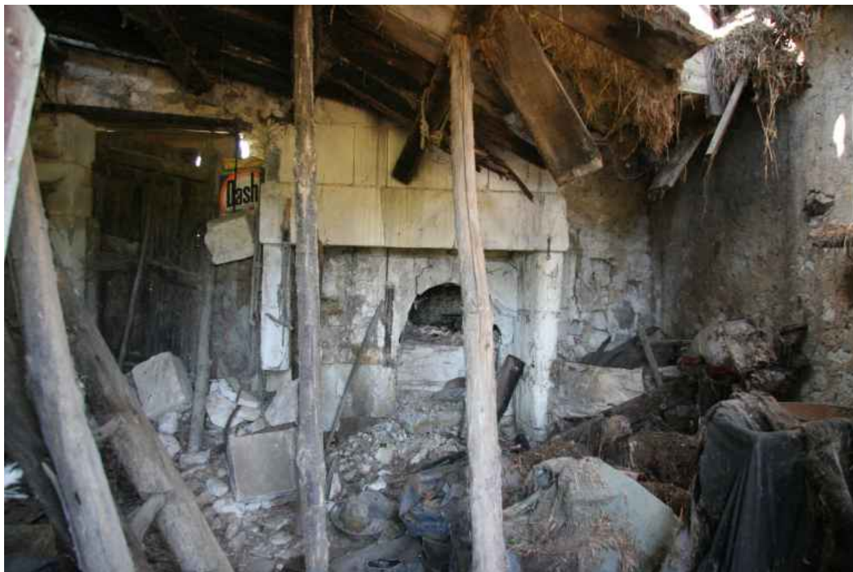
Cheminée de la buanderie rapportée sur mur goutterot.
