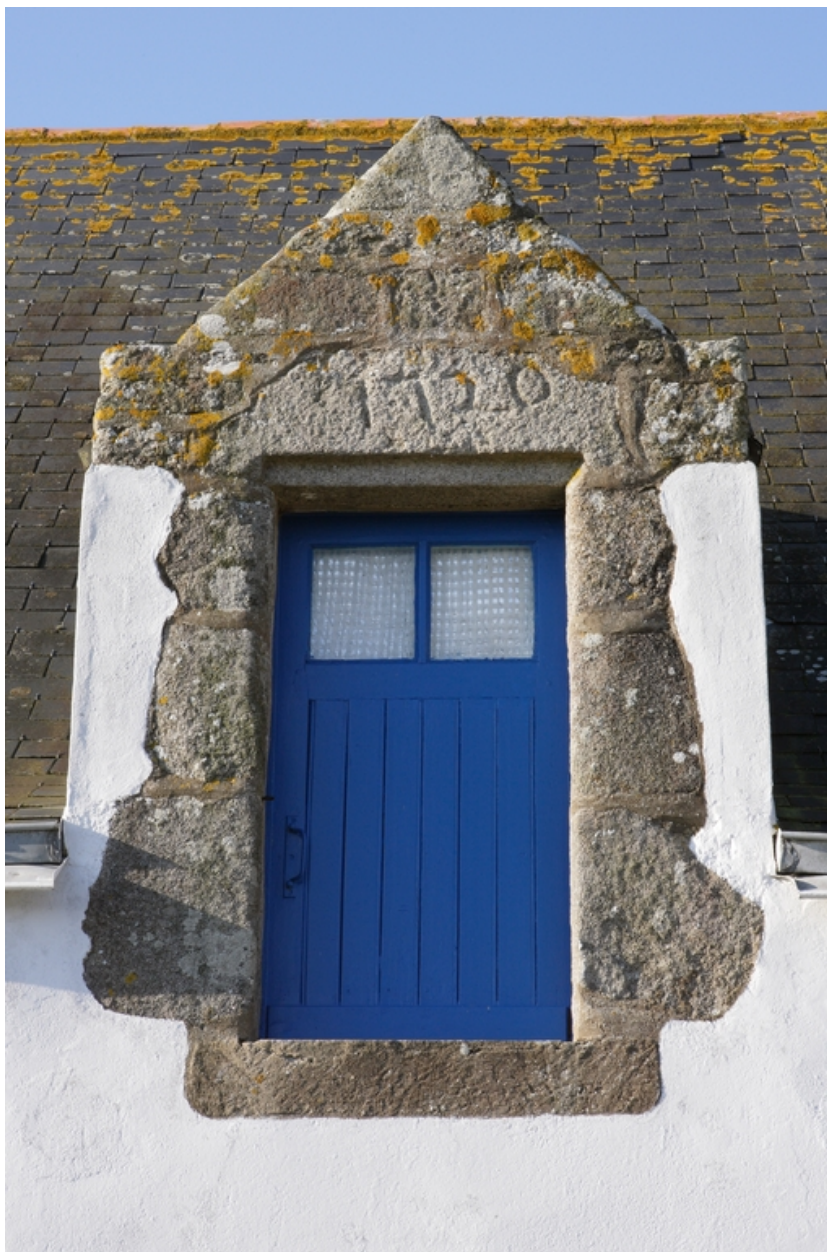
Détail de la lucarne datée 1720 du 1er logis.
