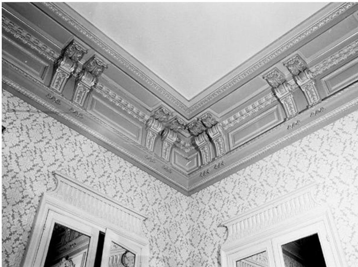
Pavillon sud-ouest, premier étage, appartement du Préfet, la grande salle à manger : détail sur la corniche, angle sud-est.
