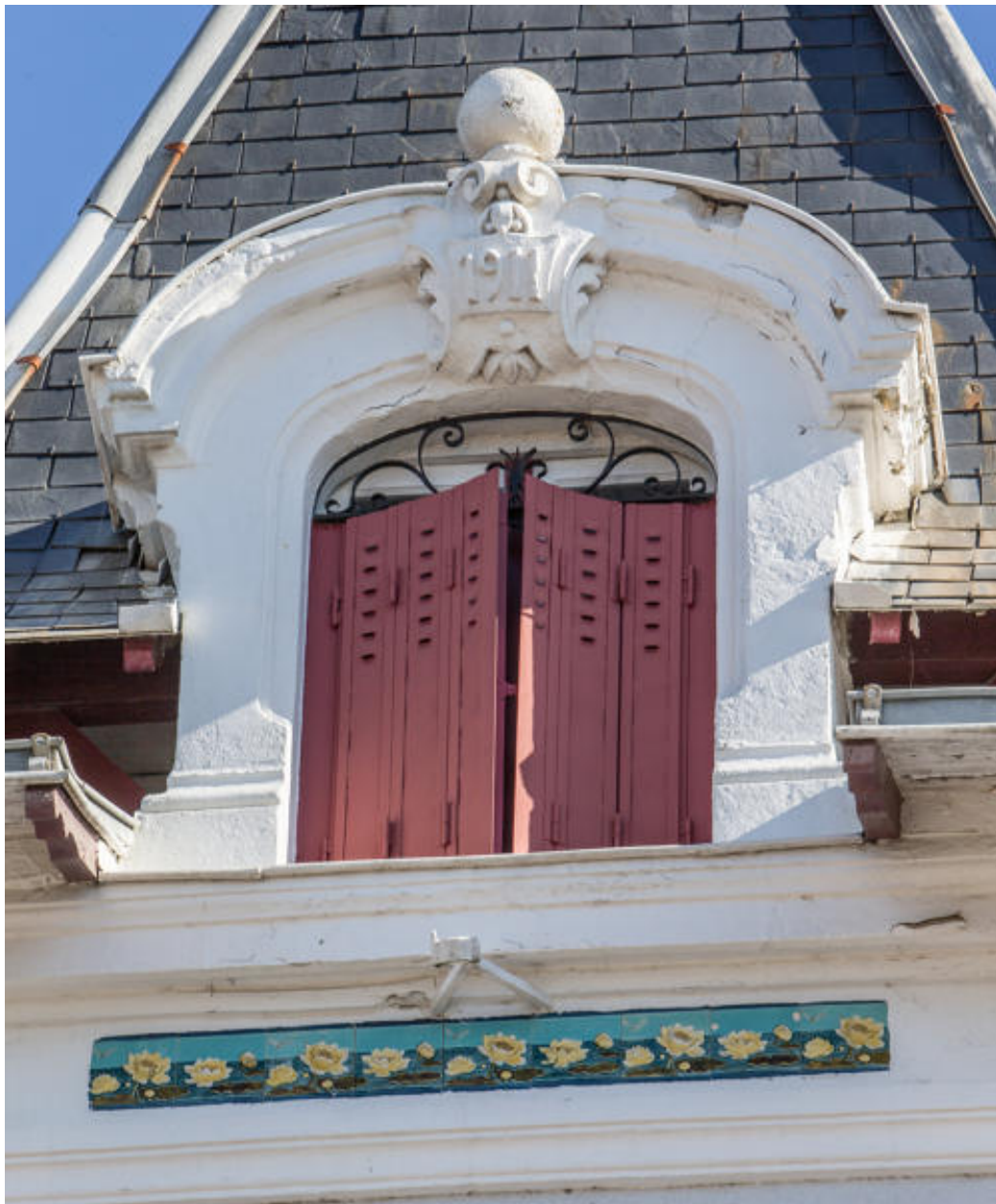
Maison, 18 rue Joseph-Tahet. Détail de la lucarne.
